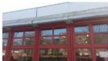
Westsicht Schwachstelle Jalousiekästen und Fensterrahmen!
